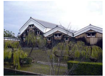
图 9.1 酿酒厂厂房(京都市伏见区)
